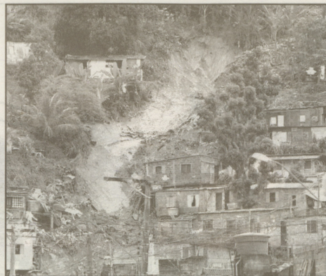
Sinal da tragédia: o deslizamento destruiu casas nas encostas
